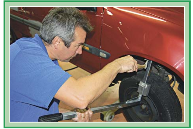
Utilisation de la batte pour reconstituer la pliure
